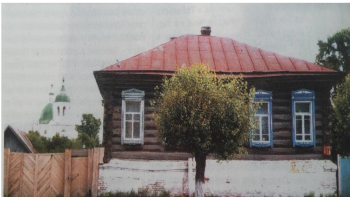
Рис. 2. Дом, в котором находилась типография газеты «Сибирский листок» (ул. Ремезова, 14). 1960-е гг.
